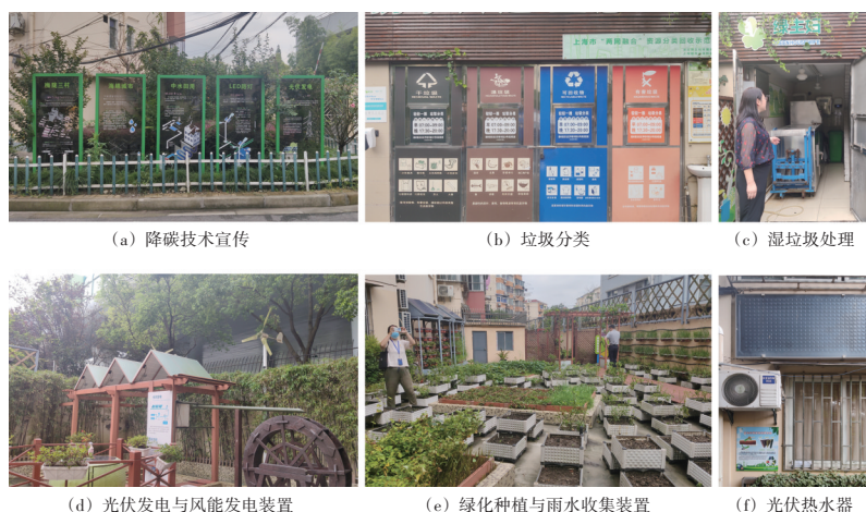
图5 社区已采用的低碳更新技术的现状照片
