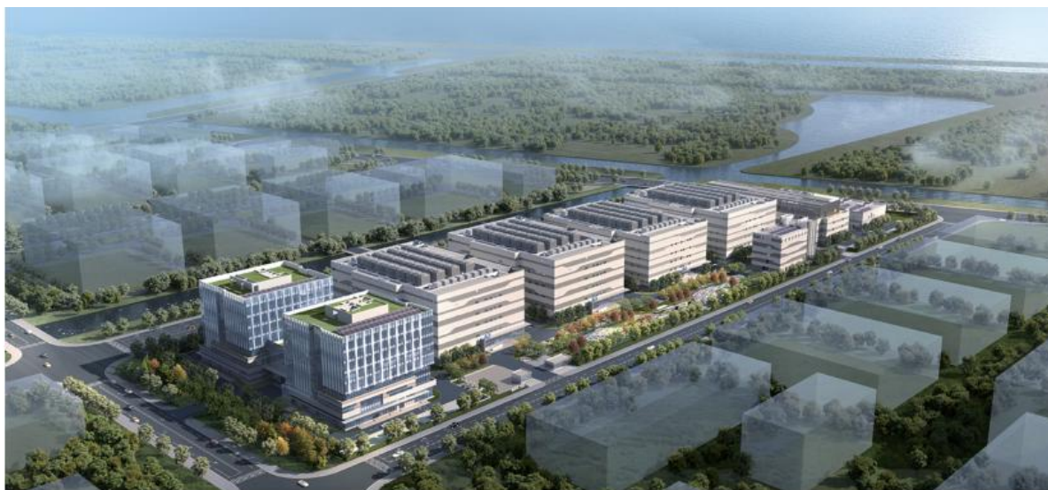
Fig. 2 Plano de la primera fase del centro de computación inteligente Lingang de China Telecom
