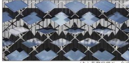
(b) 苏黎世理工：自适应光伏外墙
