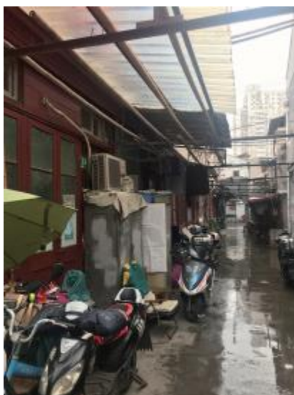
Figura 2: Estado actual de YF antes de la renovación.
