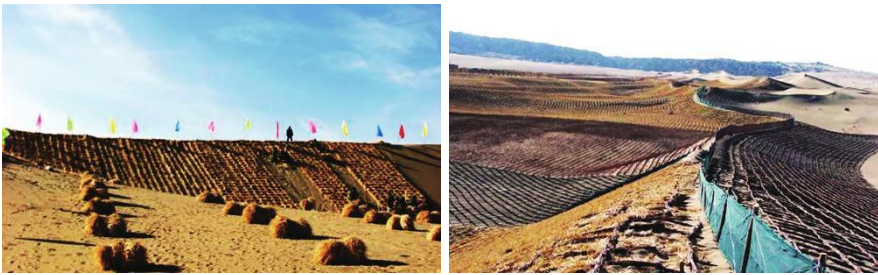
Figura 4 Proyecto de protección y utilización de las grutas de Dunhuang Mogao: Proyecto de protección contra el viento y la arena
