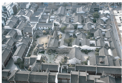
(1) 第一阶段甘熙故居修复后的建筑肌理
