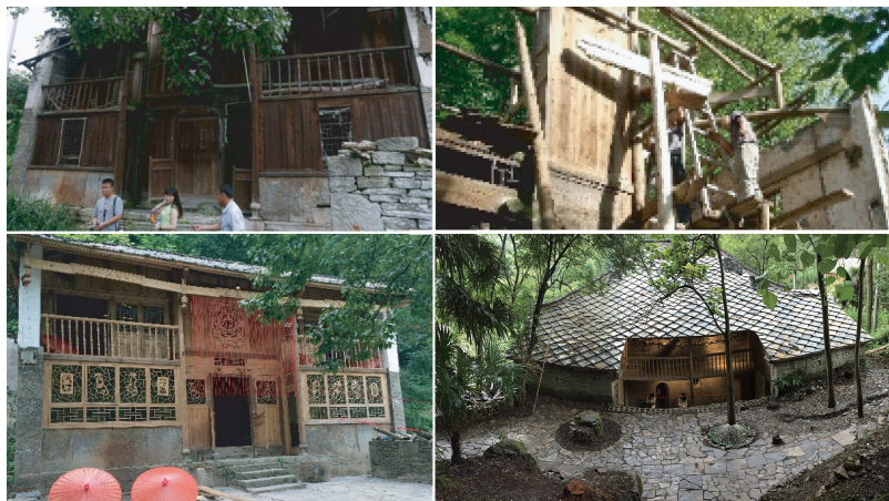
图11 金家院子修复过程
