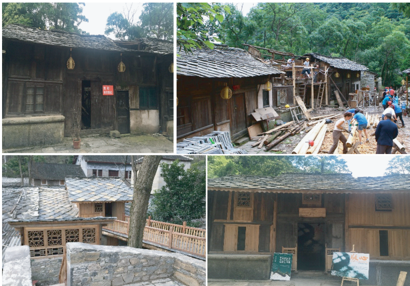
图12 金家铺子修复过程
